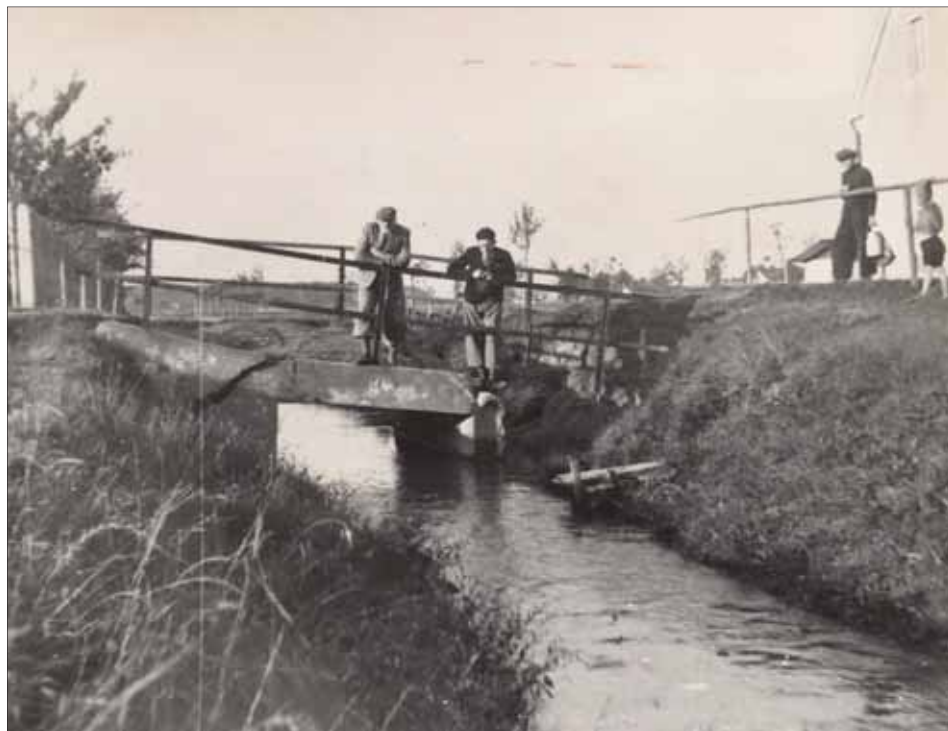
Obr. 44. Poškozený most přes potok Ščučí po povodni, 26. července 1939
