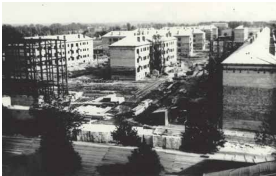
Obr. 92. Pohled z haldy na výstavbu tzv. nového Šídlovce, závěr čtyřicátých let 20. století
