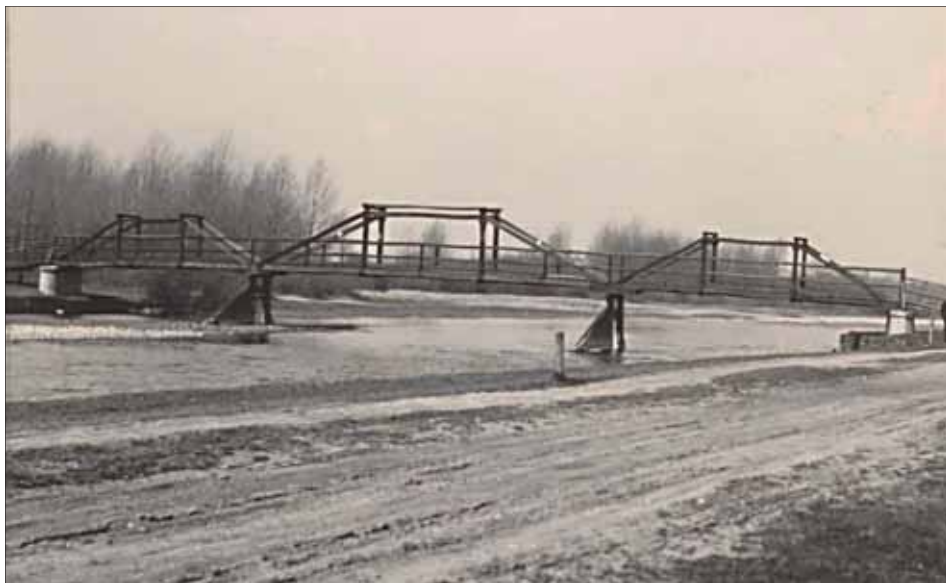
Obr. 30. Dřevěná lávka přes řeku Ostravici, dvacátá léta 20. století
