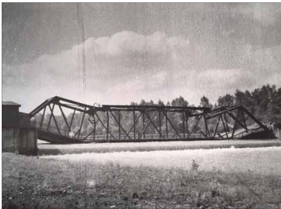
Obr. 49. Poškozený vratimovský most po průchodu východní fronty, květen 1945
