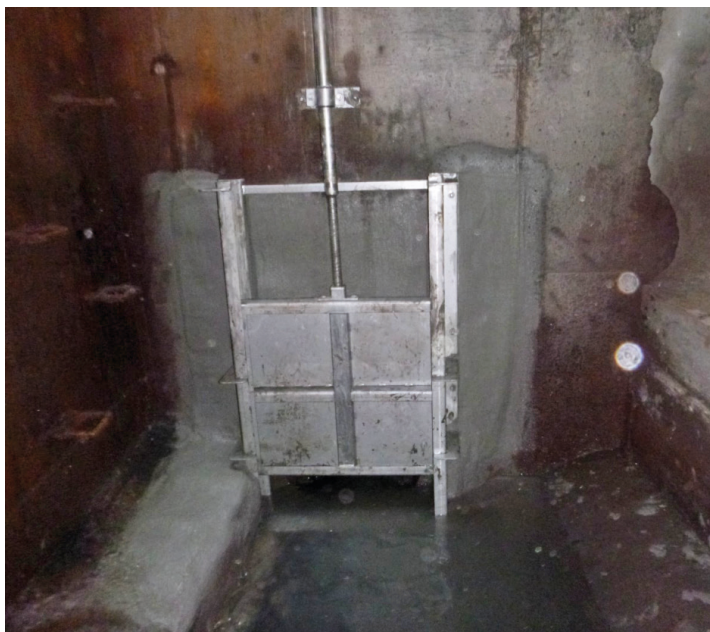
Nové stavítko na odtoku z OK Mostní po opatření (regulace 25 cm ode dna)
