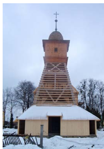
▲ Jarní dokončovací práce na hrubé stavbě kostela, 3. dubna 2004
