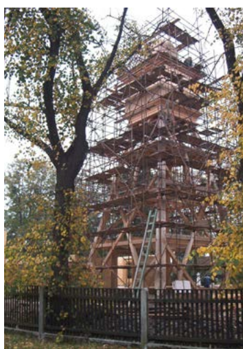
▲ Pokračující práce na zvonovém patře a zastřešení věže kostela, 29. září 2003
