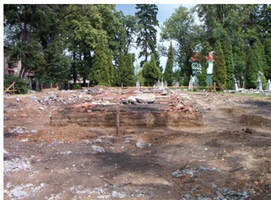
▲ Základové práce na novostavbě po posvěcení základního kamene, 5. července 2003
