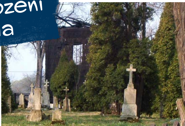
▲ Pozůstatky ohořelého torza kostela sv. Kateřiny po požáru, 2. dubna 2002
