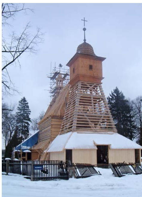
▲ Pohled na západní průčelí kostela při dokončovacích pracích na hrubé stavbě kostela, 3. dubna 2004
