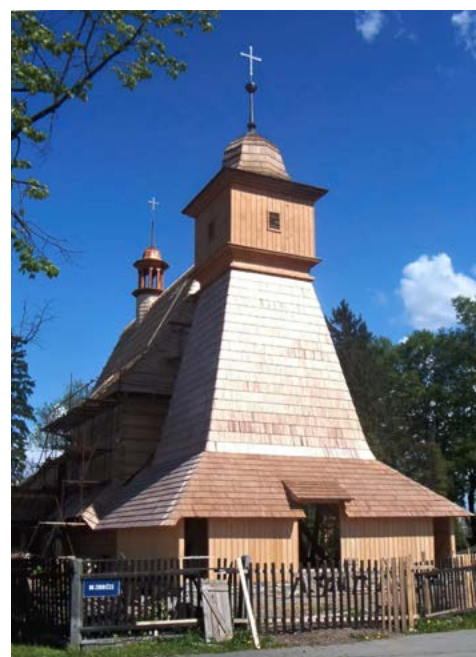
▲ Novostavba kostela po pokrytí hrubé stavby šindelí od severozápadu, 9. května 2004
