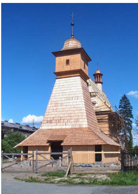
▲ Novostavba kostela po pokrytí hrubé stavby šindelí od jihozápadu, 9. května 2004
