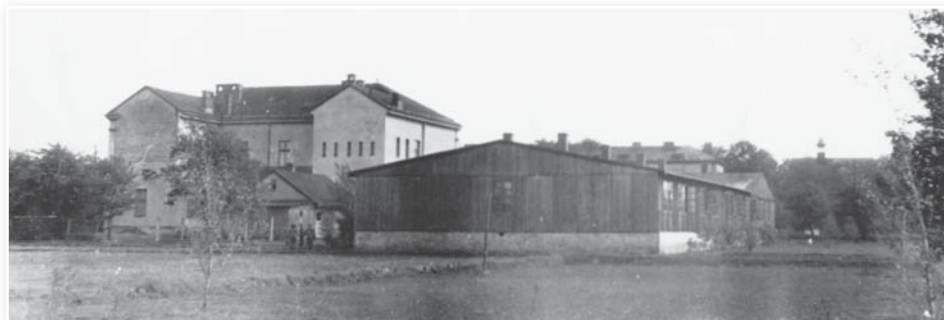
Škola s nouzovým dřevěným přístavkem.
